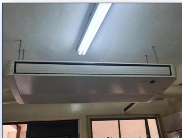
Instalación de aire acondicionado en la subse de Jalapa – Infraestructura
