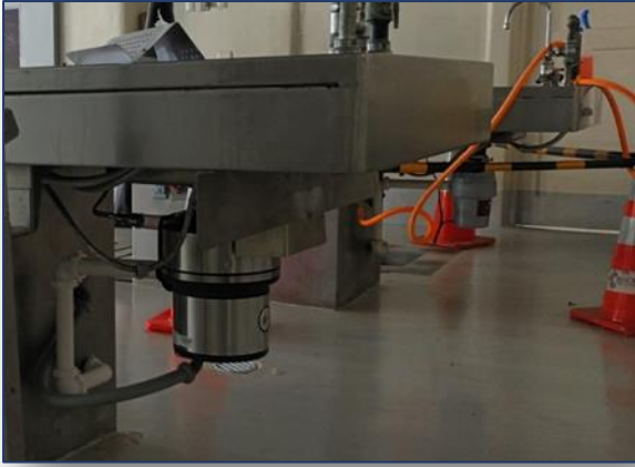
Cambio de trituradores en las mesas de necropsias – Infraestructura
