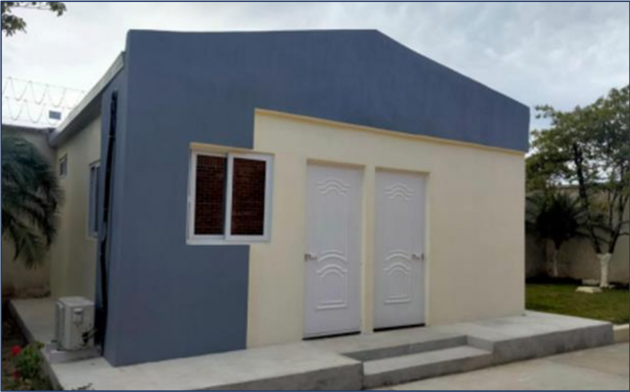
Nueva área para atención a víctimas en la sub sede de Poptún, Petén – Infraestructura
